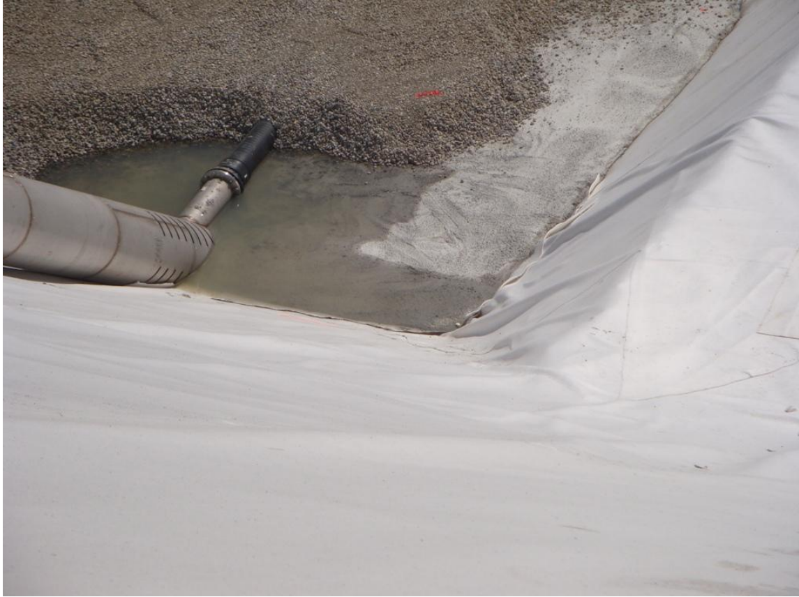
Particolare raffigurante l'angolo di raccolta del Percolato
