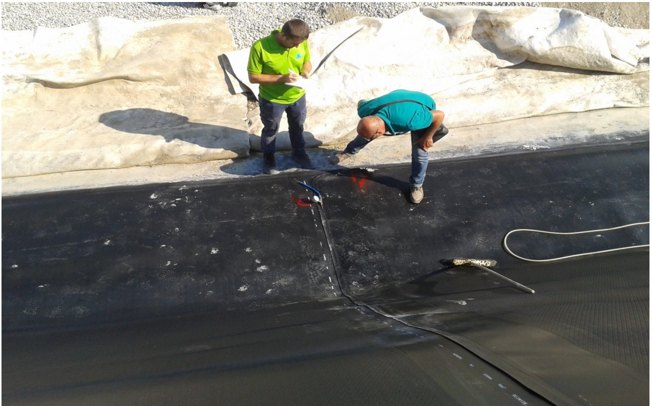
Verifica saldature del 2° telo sulla chiusura della barriera di divisione bacino 3/4
