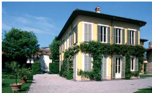
Villa Marietti (facciata di levante)
