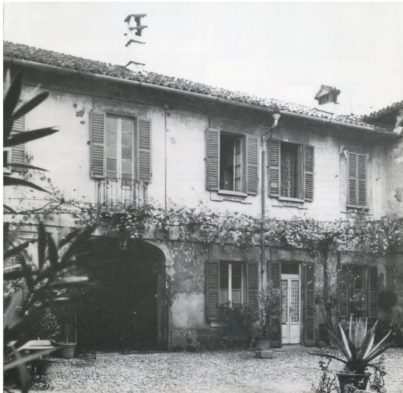
Casa Bollani - La facciata interna
