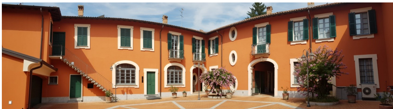
Casa Bollani - Panoramica del cortile interno
