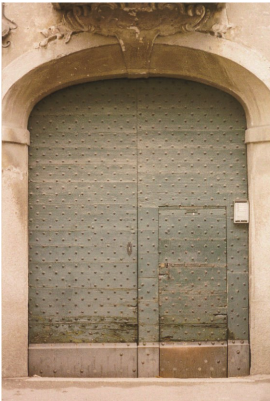
Casa Bollani - Portone di ingresso
